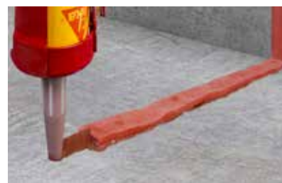
Bilde øverst: Bruk av kun tetningsmasse Bilde nederst: Tetningsmassen benyttes som lim for svellebånd.
