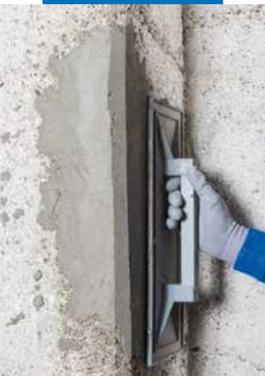
Pusse overflaten på Planitop Smooth & Repair R4 for å få en glatt finish
