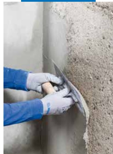
Påføre Planitop Smooth & Repair R4 med en sparkelspade
