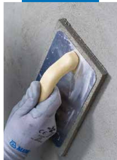
Puss overflaten på Planitop Smooth & Repair R4
