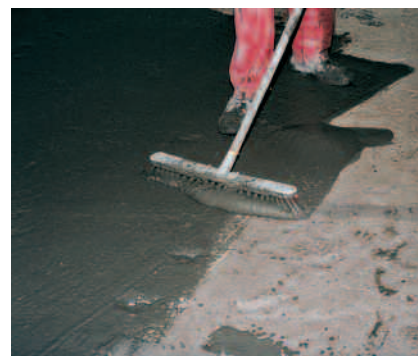
PCI Repahaft koster på underlaget. Leggemørtelen påføres deretter umiddelbart på den ferske heftbroen.
