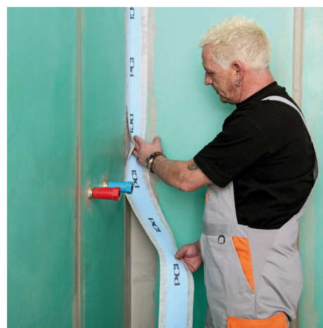
PCI Pecitape legges ned i det ferske laget med det brukte membranmaterialet.
