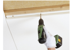
Master F monteras med skruv
