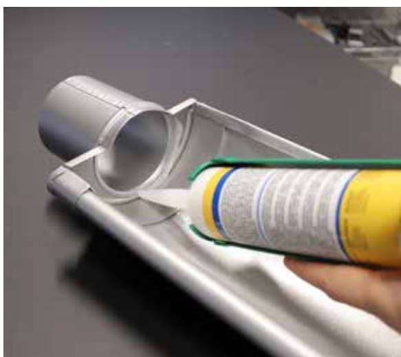
Tett innvending rundt røret med silikon.
