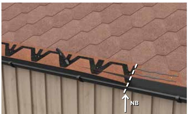
2. Legg to strenger Isola Fugemasse langs takfoten. Plasser de avkuttede shingleplatenes rygg opp til underkant av den gamle shingelens andre rad. **NB!** Det er meget viktig for takets tetthet at plateskjøten kommer i senter over den innlagte shingeltungen. Kontroller horizontalretningen med en snor eller lignende. Shingleplatene festes 2,5 cm opp for innsnittet i klebefeltet.
