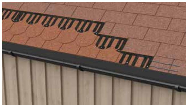
**3.** Neste rad monteres med omlegg inn til innsnittet. Forskyv platen slik at plateskjøt kommer over monteringsspor på underliggende shingelplates rygg. Resterende rader monteres tilsvarende.
