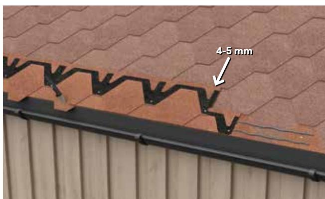
3. Monter neste shingelrad 4-5 mm fra tungen til gammel shingels tredje rad. Forskyv platene slik at den første rads klebefelt dekkes og tunga passer i underliggende rads innsnitt. Festemiddel skal plasseres ca 2,5 cm over hvert innsnitt. Alle tunga på utsiden av takfoten skjæres bort.
