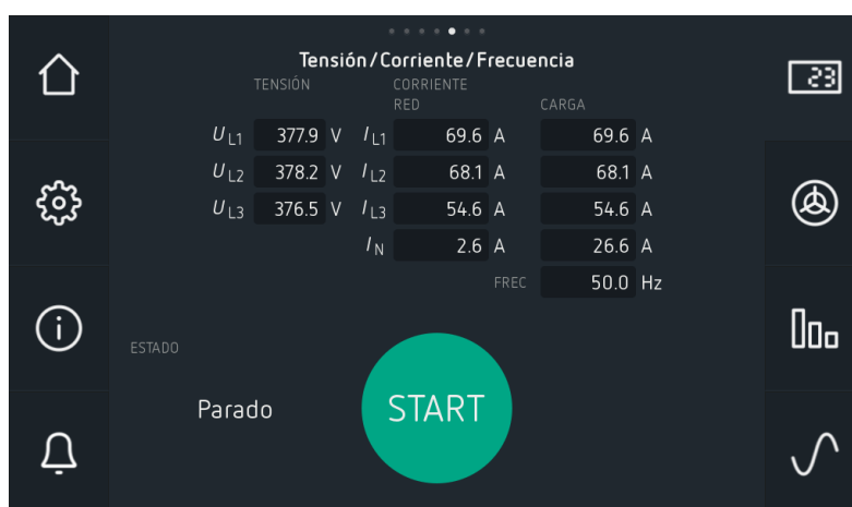
Figura 50: Visualización de la Tensión, Corriente y Frecuencia.
