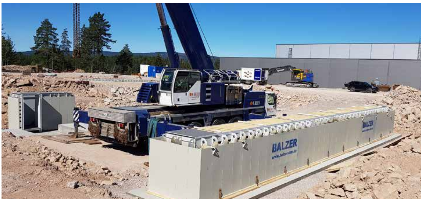
20 m. lang arbeidsgrav nivellert og festet på betongsåle.
