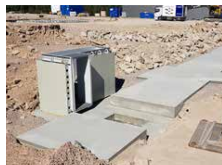
Her kommer en 28 m. inspeksjonsgrav med sidedgang og spillvannsump
